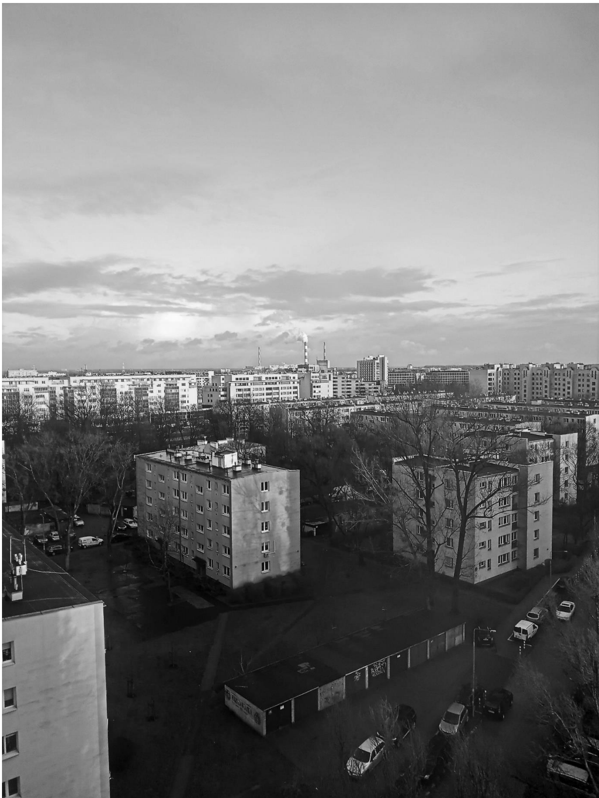
Rysunek 2 Widok na Elektrociepłownię Siekierki, działającą w Warszawie od 1961 r.
