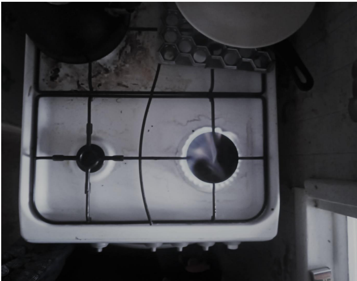
Rysunek 4 Włodzimierz Pessel, w tekście dla Autoportretu, użył określenia „trzewia miasta”, na całą instalację i infrastrukturę ciepłowniczą, wodociągową, elektryczną.
